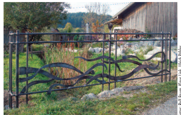
Eine erste Probemontage des Geländers, noch fehlen einzelne Elemente
